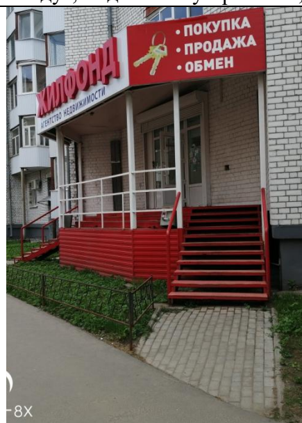
Агентство недвижимости «Жилфонд» (ООО «Жилфонд») Адрес: г. Архангельск, ул. Гайдара, д. 10 Результаты (состояние объекта): вход в агентство не оборудован пандусом /подъемным устройством/кнопкой вызова
